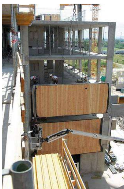
Рис. 14. Монтаж деревянных панелей наружных стен на железобетонный каркас здания в Вене (комплекс зданий D12 в новом Seestadt Aspern)
