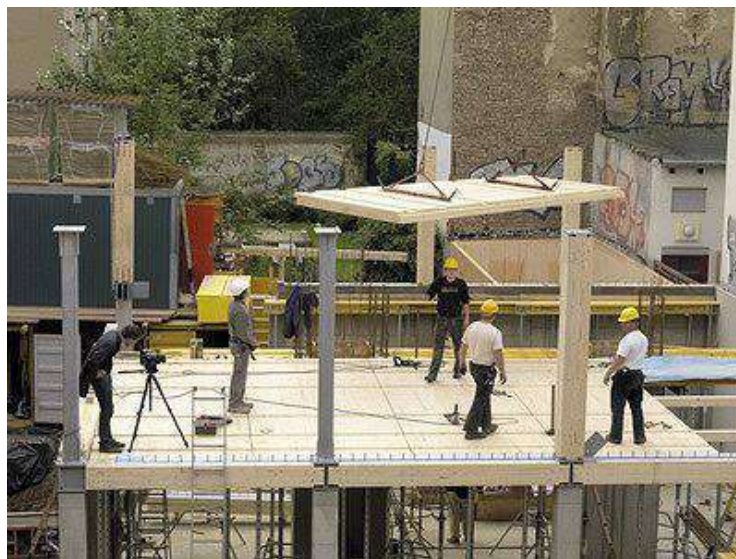
Рис. 10. Монтаж массивных деревянных панелей перекрытия на металлическую конструкцию при строительстве здания в Берлине
