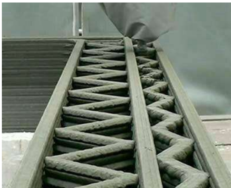
Рис. 1. Наружная стена в процессе 3D печати
